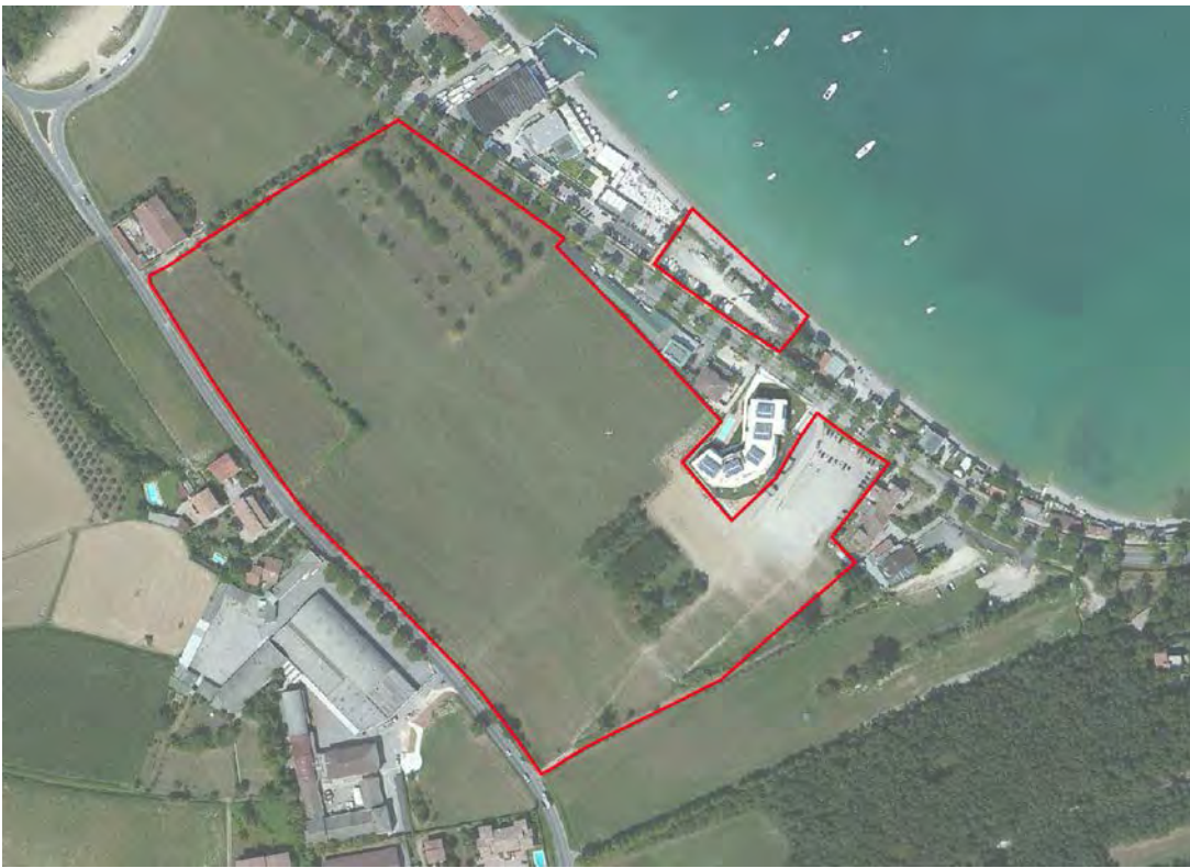
Figura 4. Vista dell'area d'intervento.
