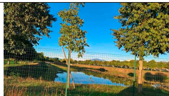
Foto 8 vista della vasca di laminazione del complesso commerciale "IL Leone"
