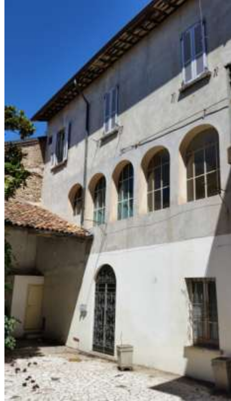
Fronte interno alla corte edificio principale
