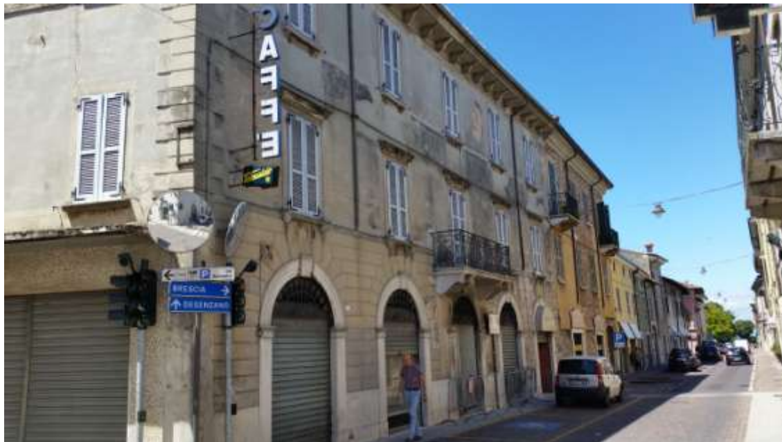
Fronte su via G. Garibaldi
