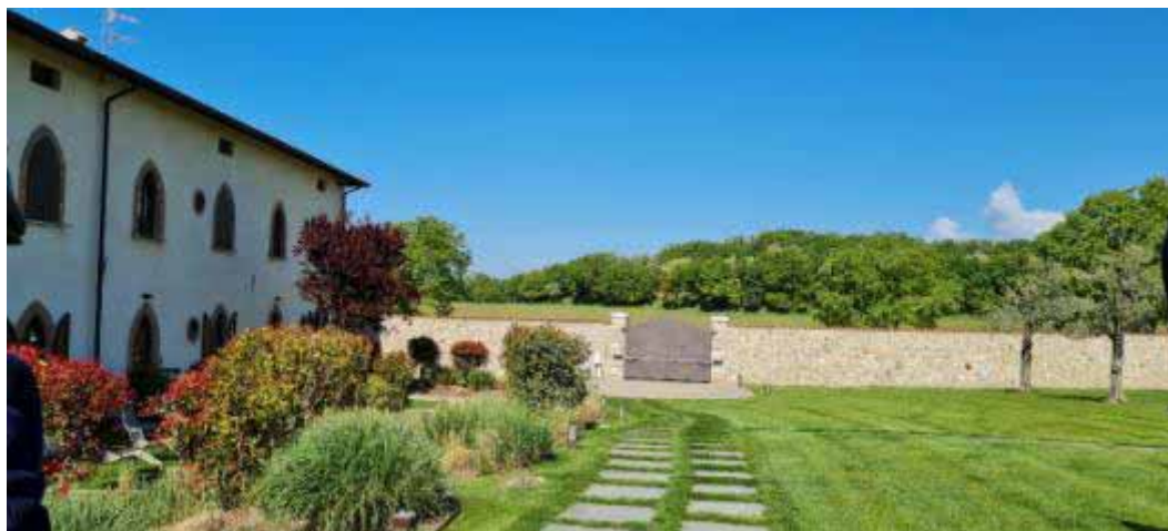
foto 2 _ il fronte della CAV e l'area esterna verso ovest
