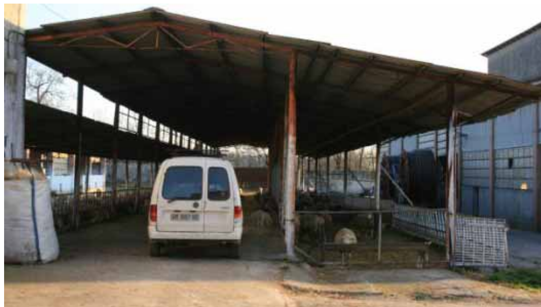
foto 5 _ gli edifici a destinazione agricola oggetto di demolizione
