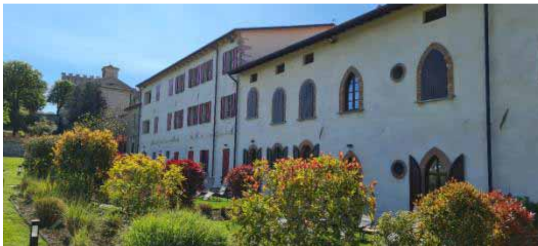
foto 1 _ il fronte della cascina ristrutturata e destinata a casa vacanze
