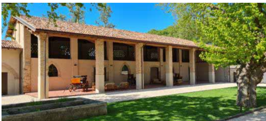
foto 3 _ le barchesse della corte già oggetto di intervento di recupero
