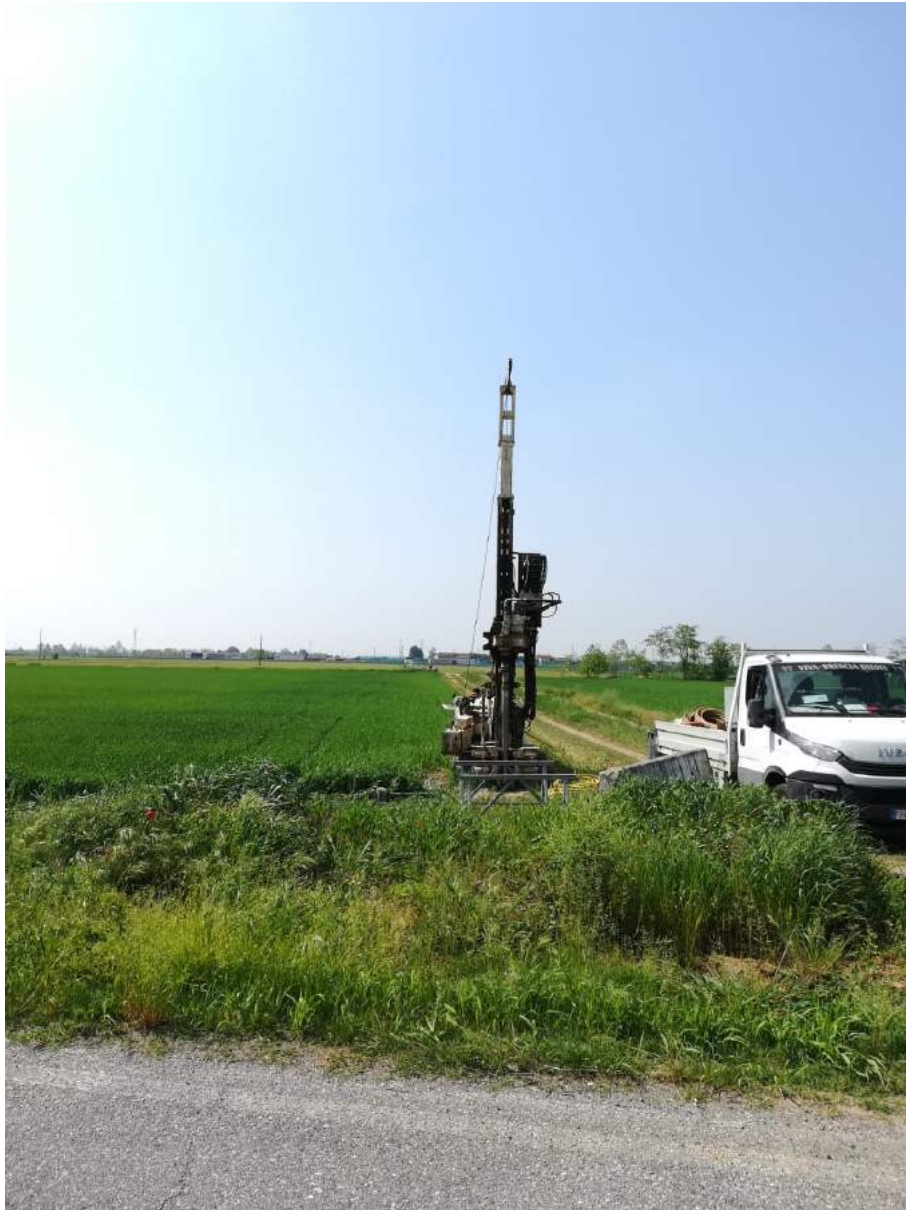
SONDAGGIO S3 – Postazione
