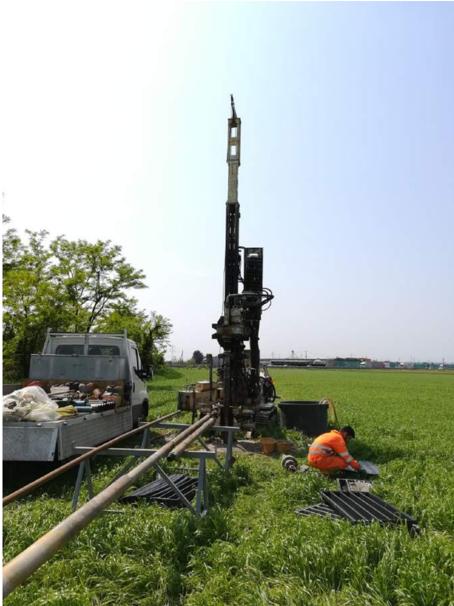
SONDAGGIO S2 – Postazione
