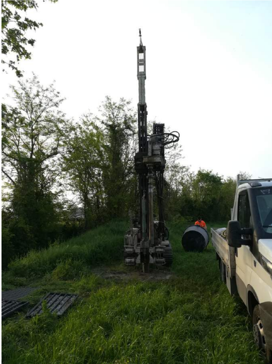
SONDAGGIO S1 – Postazione
