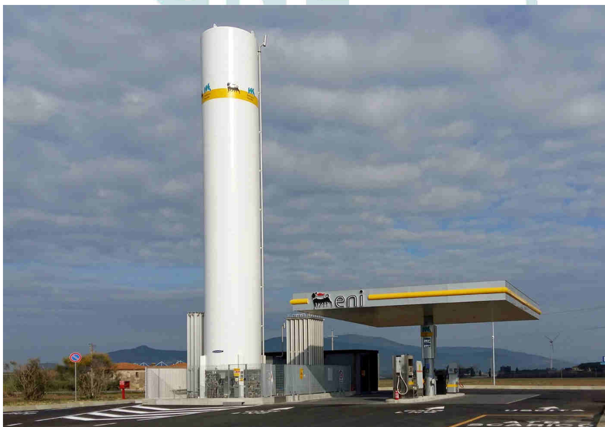
Sopra l'impianto GNL di Novi Ligure con un serbatoio da 80 m 3 con h 18 m, sotto quello ENI di Pontedera con un 100 m 3 , con h 22 m. Ambedue hanno un diametro di 3 m.
