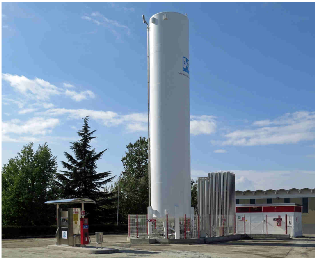
Sopra l'impianto GNL di Novi Ligure con un serbatoio da 80 m 3 con h 18 m, sotto quello ENI di Pontedera con un 100 m 3 , con h 22 m. Ambedue hanno un diametro di 3 m.
