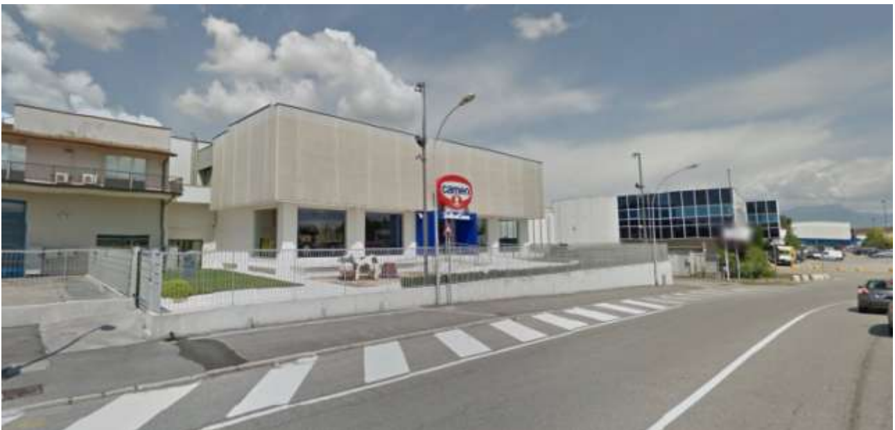
Figura 5.3—3 Foto 1 del fronte attuale in affaccio su Via Ugo la Malfa
