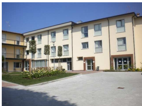
PROSPETTO VERSO IL CORTILE DOPO I LAVORI DEL 2009
