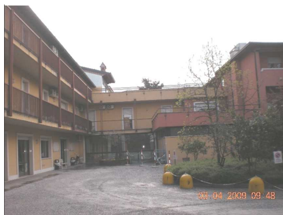
PROSPETTO VERSO IL CORTILE PRIMA DEI LAVORI
