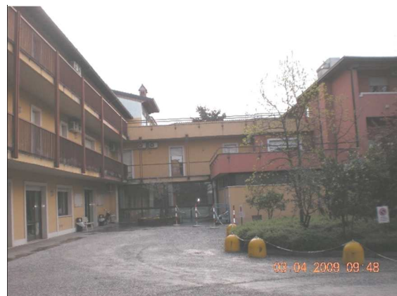
PROSPETTO VERSO IL CORTILE PRIMA DEI LAVORI
