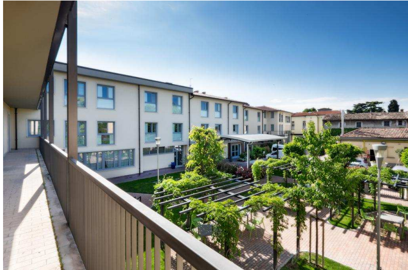
Vista da immobile CURE INTERMEDIE verso RSA- Hospice-ambulatori esterni
