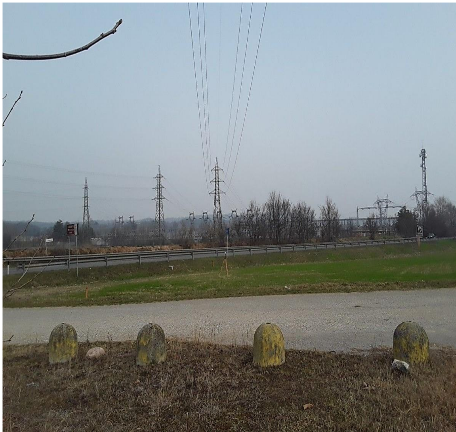
Figura 2 - foto punto di misura P1
