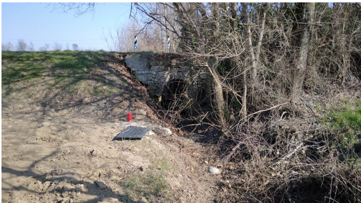
Manufatto di sottopasso strada comunale a Est dell'AdT13 [119-120]
