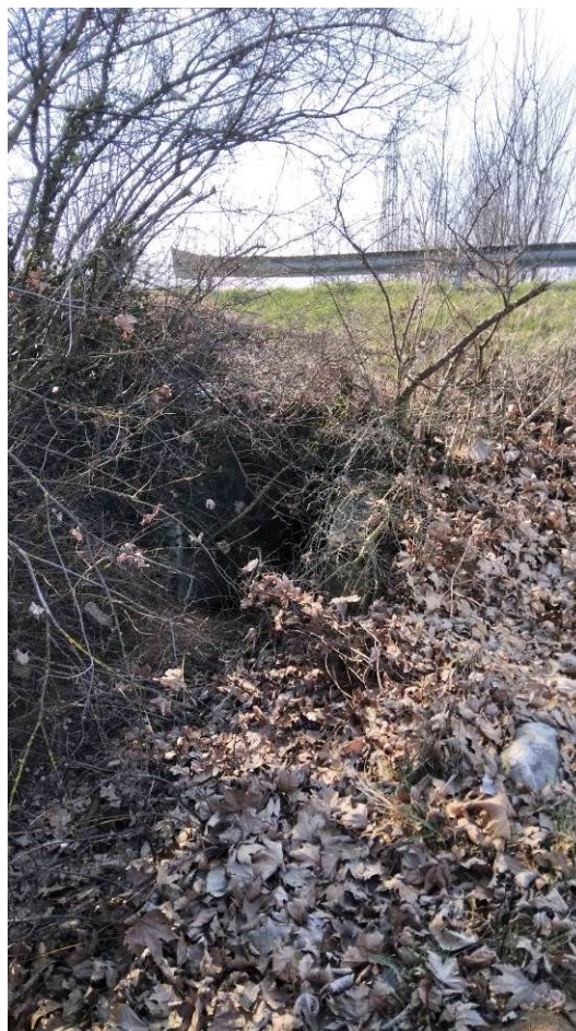
Manufatto di immissione - Sezione a valle
