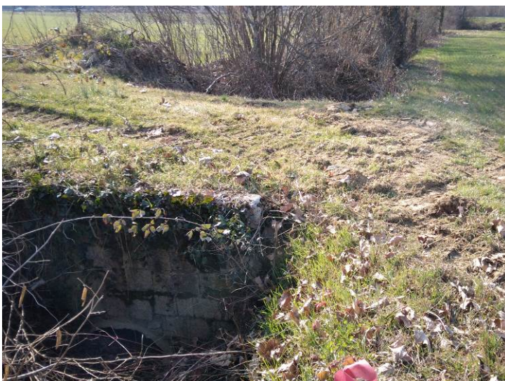
Viste da valle del ponte-tubo del tratto [111-112]
