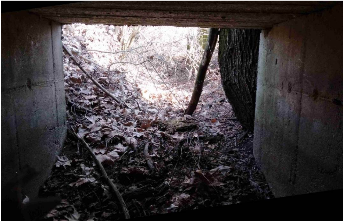
Sezione di valle [108] del manufatto 1.60x1.60m parzialmente occluso
