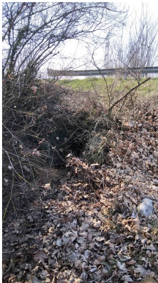
Manufatto di immissione - Sezione a valle
