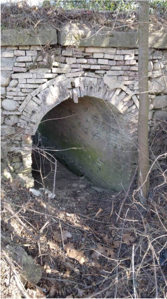
Manufatto di sbocco – Sezione a monte [119]
