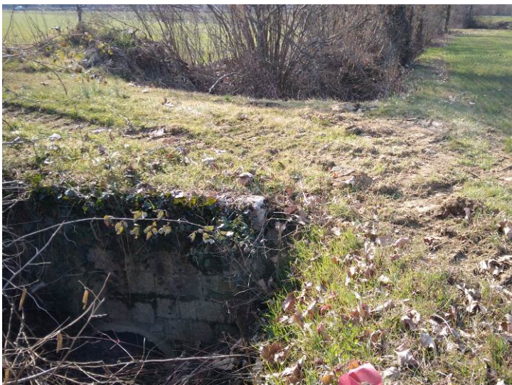
Viste da valle del ponte-tubo del tratto [111-112]
