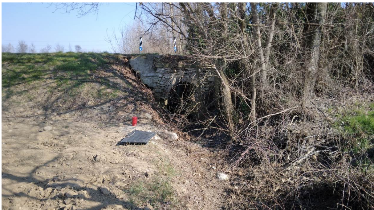
Manufatto di sottopasso strada comunale a Est dell'AdT13 [119-120]
