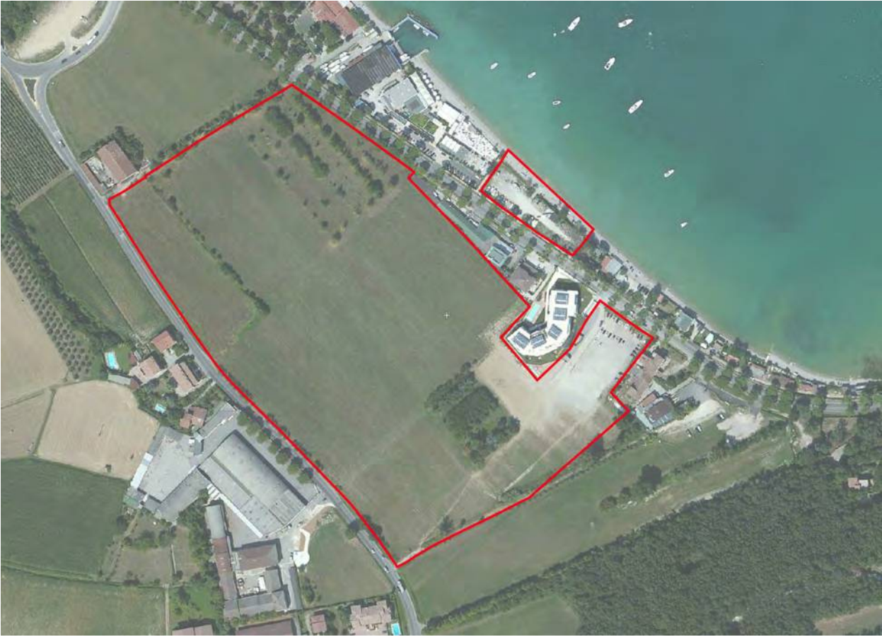
Figura 4. Vista dell'area d'intervento.
