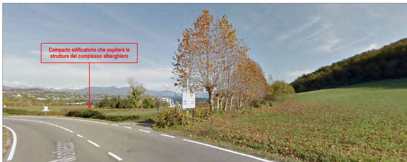
Foto C2: visuale dalla via Remato in direzione Padenghe s/G; sono sempre evidenti la macchia boschiva e il filare di elementi arborei di cui alla precedente fotografia. Mentre, appena superato quest'ultimo, appare evidente la porzione delle aree di progetto in cui saranno edificate le strutture del complesso alberghiero.
