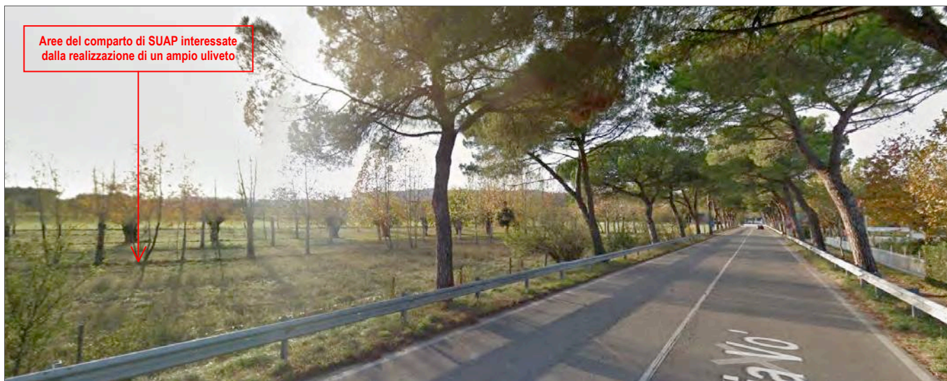
Foto D6: visuale dalla via Catullo in direzione Padenghe s/G; per la descrizione vedasi la didascalia alla precedente fotografia D5.
