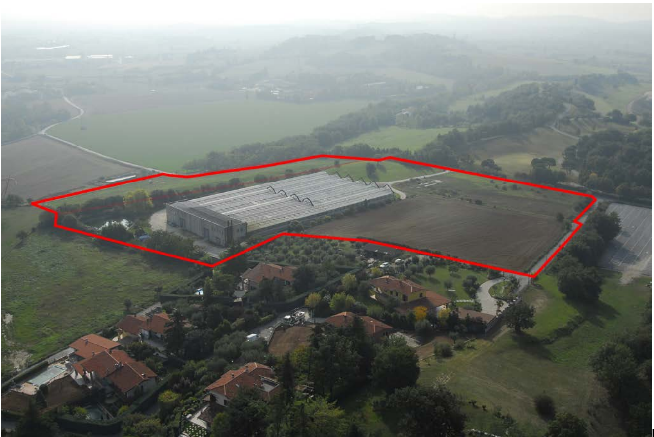
to 2 - Ripresa aerea dell'area d'intervento, vista nord-ovest.
