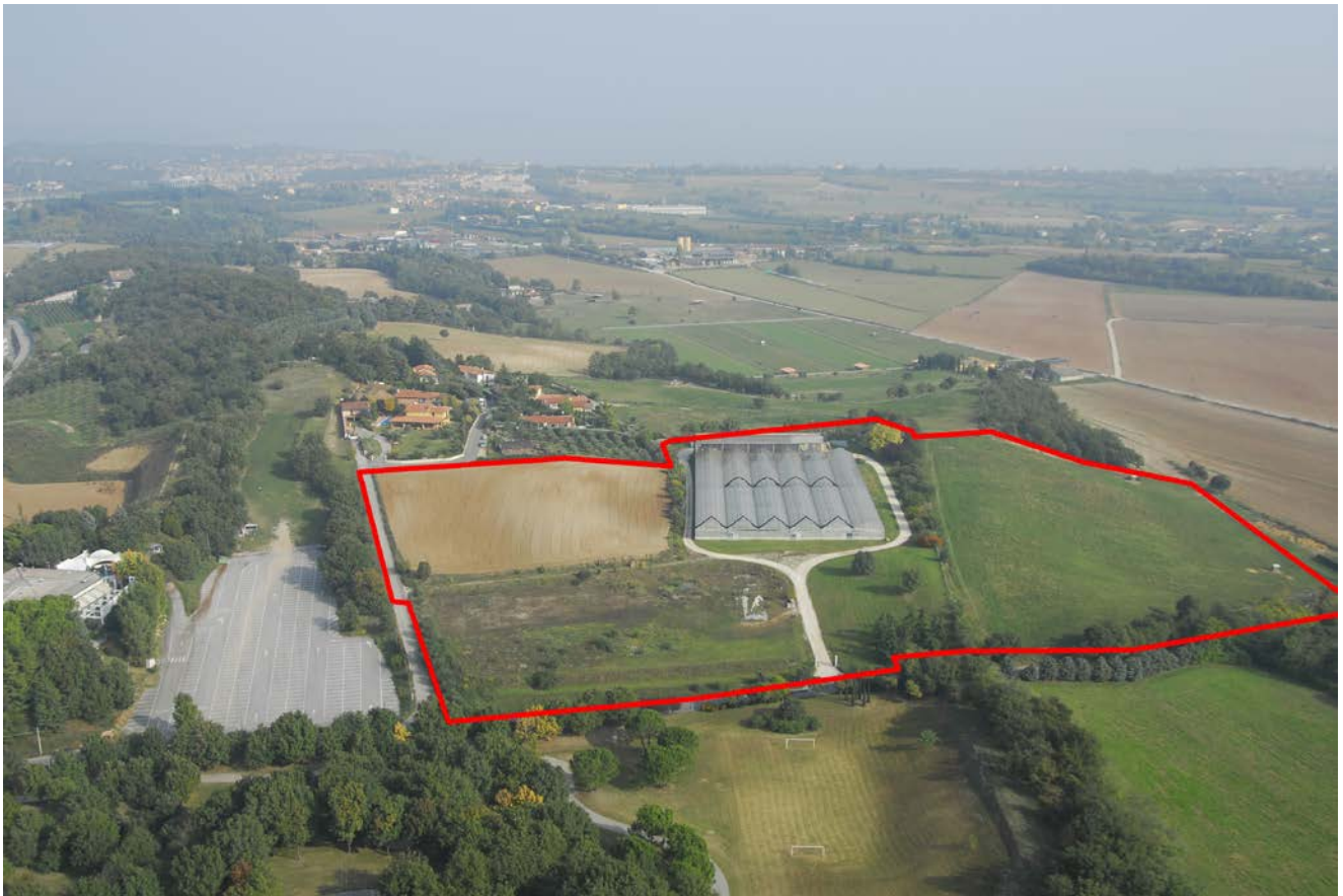
Foto 9 - Ripresa aerea delle aree d'intervento, vista da sud.
