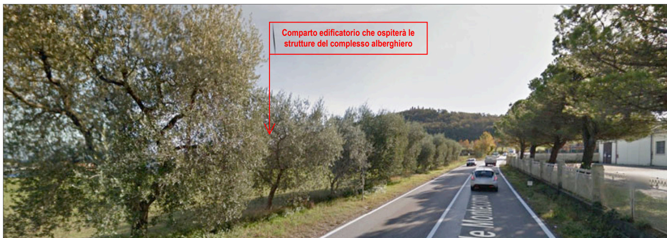
Foto B4: visuale dalla via Remato in direzione Desenzano d/G; si evidenzia il filare esistente di ulivi che occlude la visuale in direzione delle aree di progetto, nello specifico la porzione di ambito oggetto delle future edificazioni, mentre le aree edificate nonché il filare di pini marittimi a destra occludo la visuale verso l'entroterra
