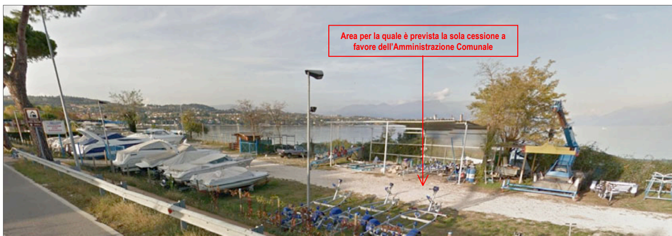
Cono ottico 7 – Panorama dal cono ottico posto sulla via Catullo - SP ex 572 in direzione della porzione di area che sarà oggetto di cessione a favore dell'A.C. (per le modalità si veda la Relazione urbanistica allegata).
