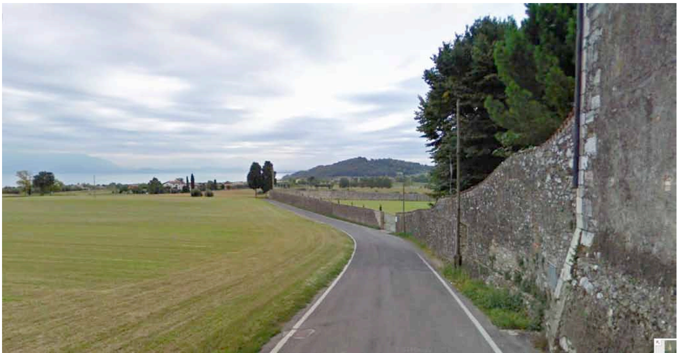
Figura 15. Sito dell'Abbazia di Maguzzano. Sul crinale morenico il convento ha una vista privilegiata sul territorio sottostante. L'edificio di particolare rilevanza architettonica è inserito in un contesto pregevole dal punto di vista paesaggistico. Si nota il rilievo del Monte Corno e il profilo del lago. L'area di progetto non interferisce nella visione di paesaggio circostante.
