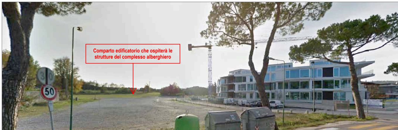
Foto D2: visuale dalla via Catullo in direzione Padenghe s/G; appare visibile la porzione di comparto di SUAP che si protende verso la via Catullo e che sarà riservata alla realizzazione degli edifici dell'albergo in linea con il "Bristol".
