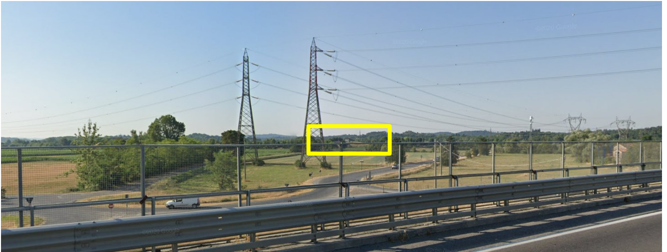
Vista dell'area lungo Via Mantova in corrispondenza dell'intersezione con Via del Benaco (direzione sud)
