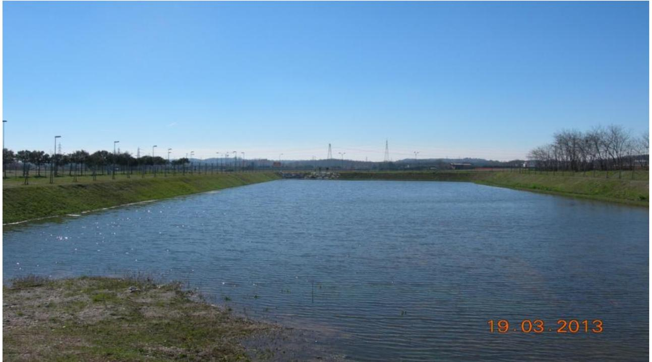
Le opere realizzate, di fatto, consentono oggi e/o sono predisposte per il collettamento, l'accumulo e lo scarico controllato delle acque drenate dai bacini afferenti direttamente od indirettamente all'area del centro commerciale "Il Leone", vale a dire:
