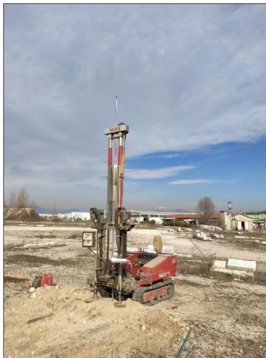
Esecuzione Prova Penetrometrica P6
