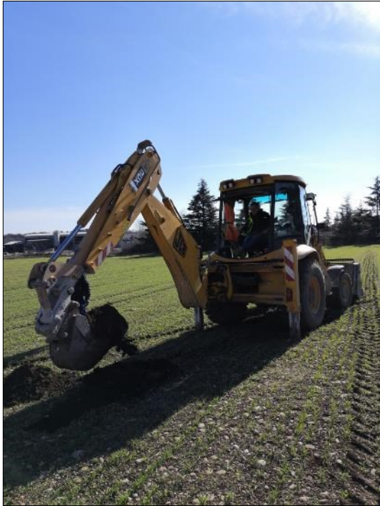
Postazione scavo esplorativo – T4
