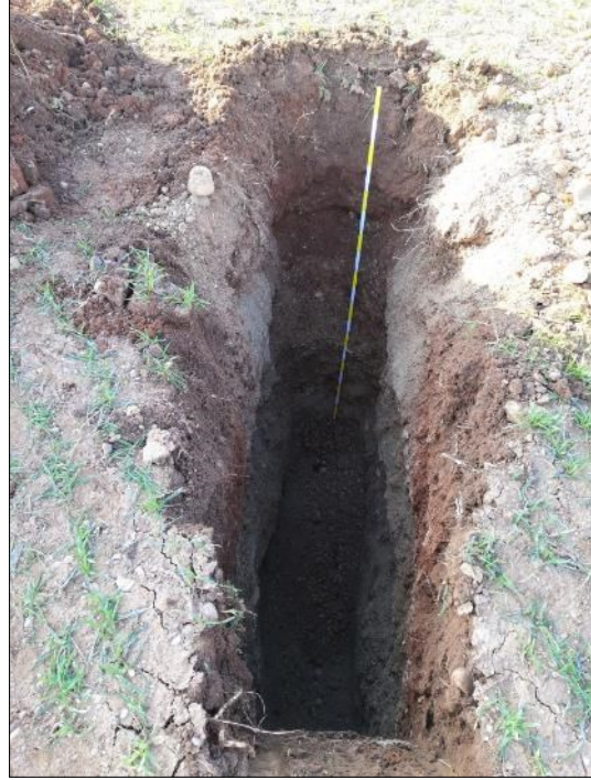
Scavo esplorativo – T2
