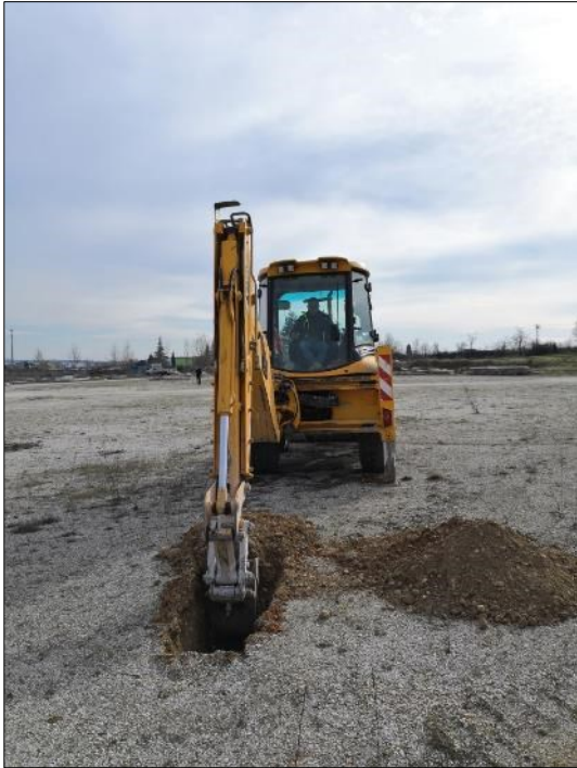
Postazione scavo esplorativo – T10
