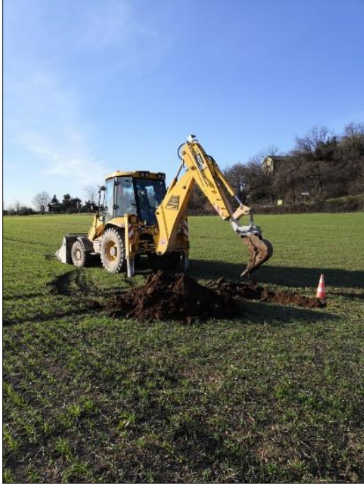
Postazione scavo esplorativo – T2
