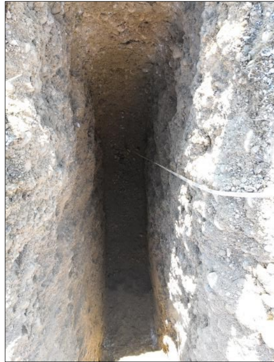
Scavo esplorativo – T7
