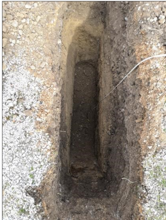
Scavo esplorativo – T9
