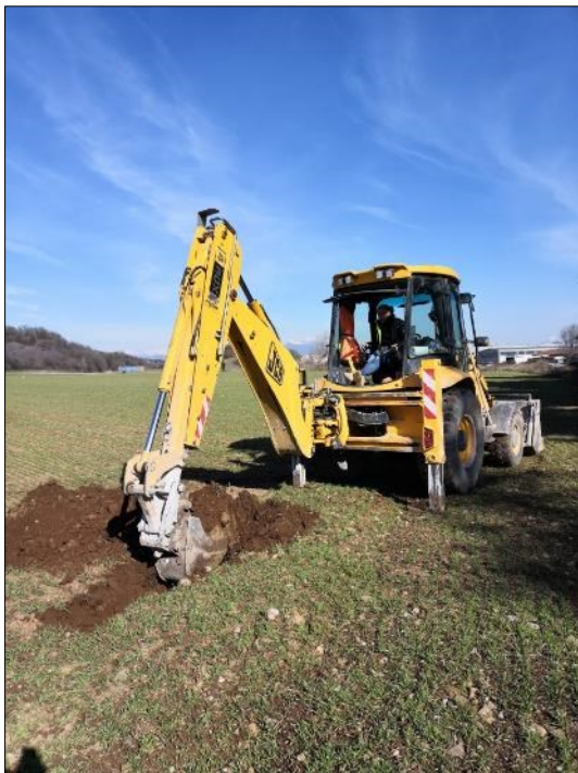
Postazione scavo esplorativo – T5
