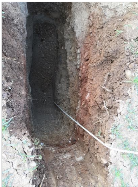
Scavo esplorativo – T1
