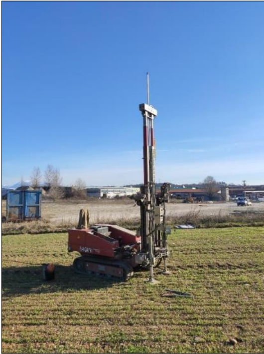
Esecuzione Prova Penetrometrica P3
