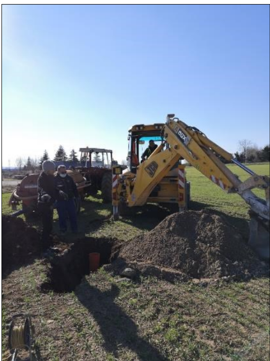
Postazione scavo esplorativo – T1
