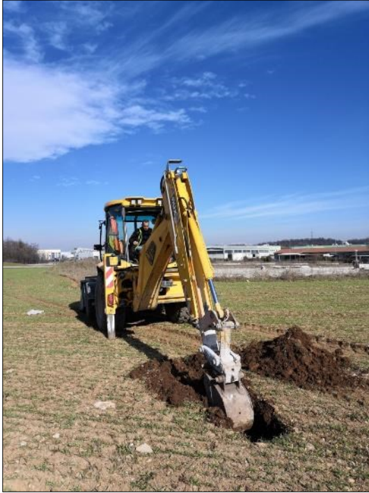
Postazione scavo esplorativo – T8
