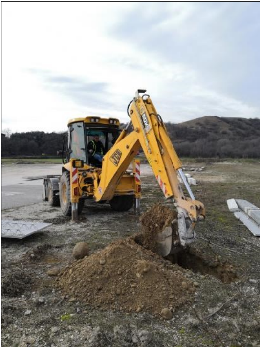
Postazione scavo esplorativo – T11
