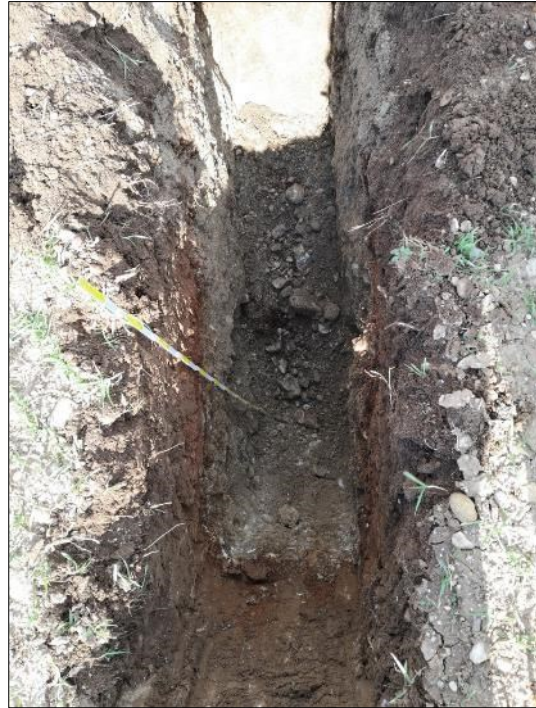
Scavo esplorativo – T8
