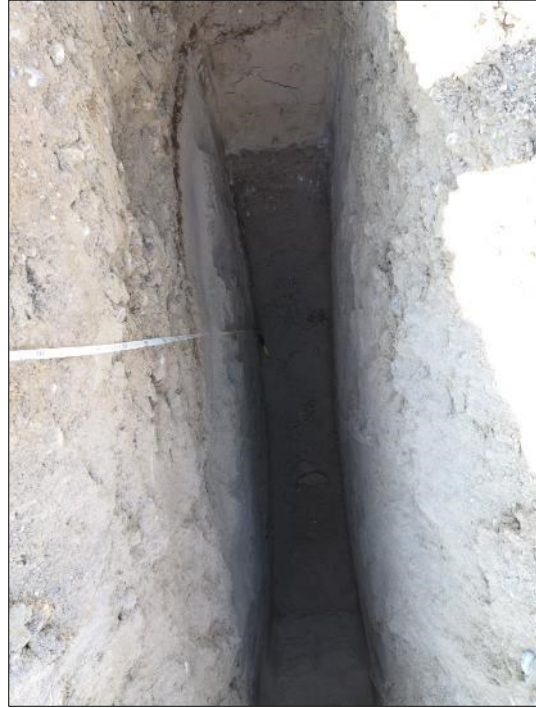
Scavo esplorativo – T6
