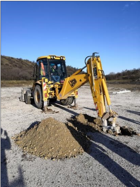
Postazione scavo esplorativo – T3
