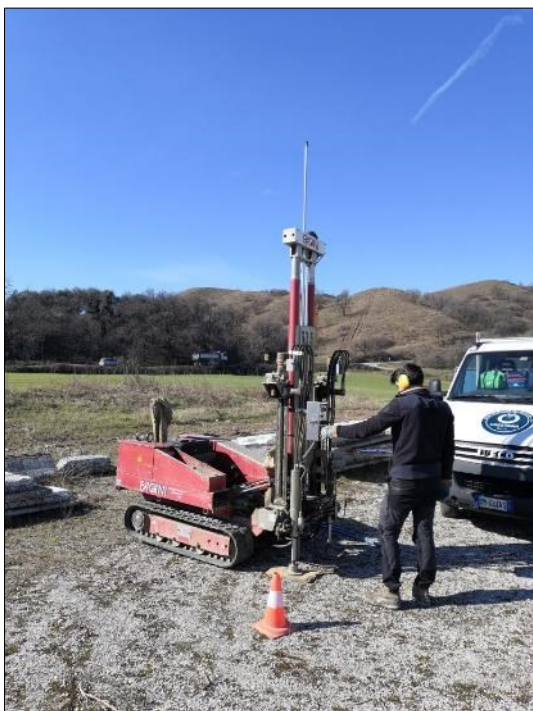
Esecuzione Prova Penetrometrica P5
