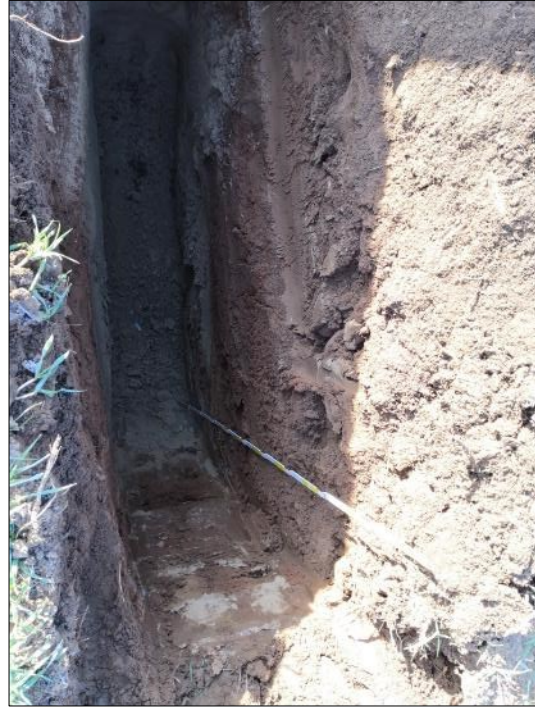
Scavo esplorativo – T4
