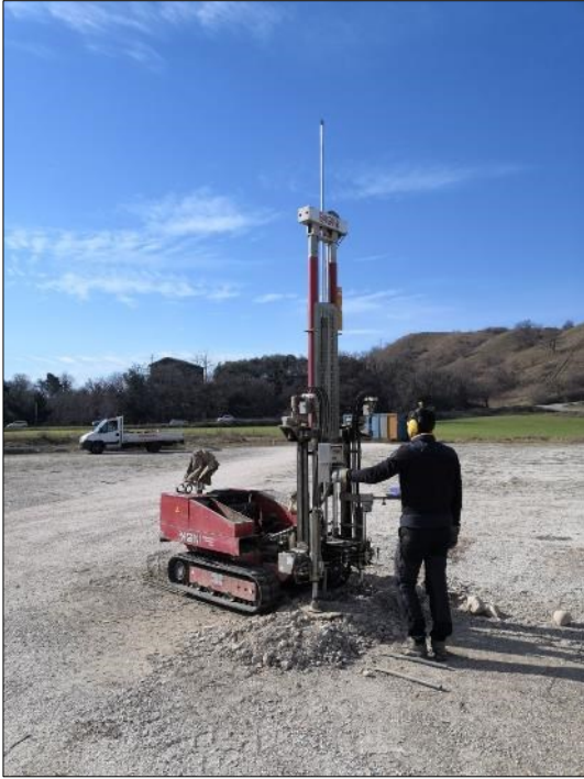
Esecuzione Prova Penetrometrica P1bis
