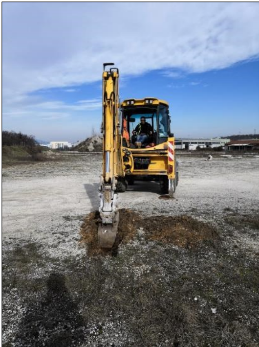
Postazione scavo esplorativo – T9
