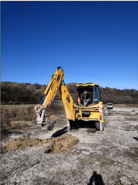
Postazione scavo esplorativo – T7
