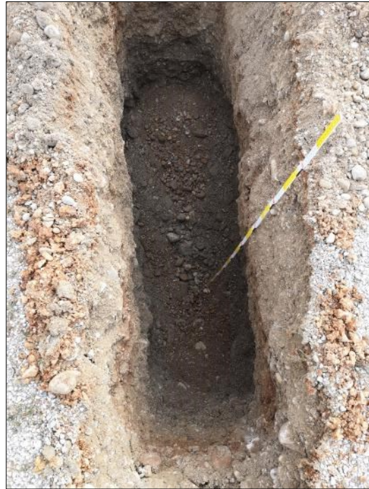
Scavo esplorativo – T10
