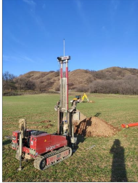
Esecuzione Prova Penetrometrica P2
