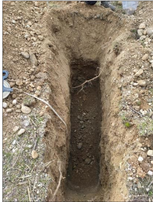
Scavo esplorativo – T11
