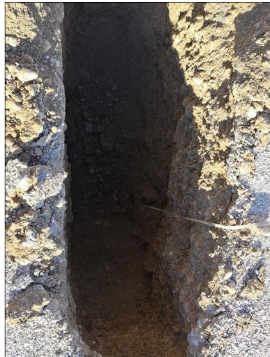
Scavo esplorativo – T3
