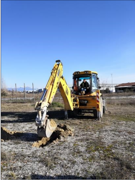
Postazione scavo esplorativo – T6
