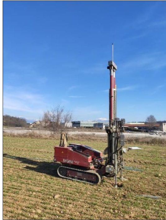
Esecuzione Prova Penetrometrica P4
