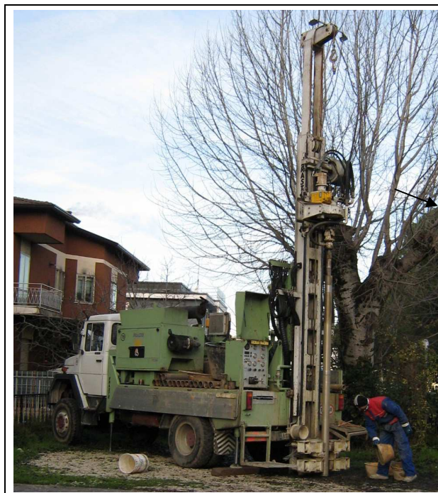
Fig. n.16 – Sondaggio geognostico effettuato in adiacenza del confine est del nuovo ambito di intervento (foto vista da est)
