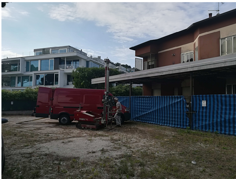
Fig. n.18 – Prova penetrometrica DPSH n.1 ed ambito di intervento visti da nord-ovest
