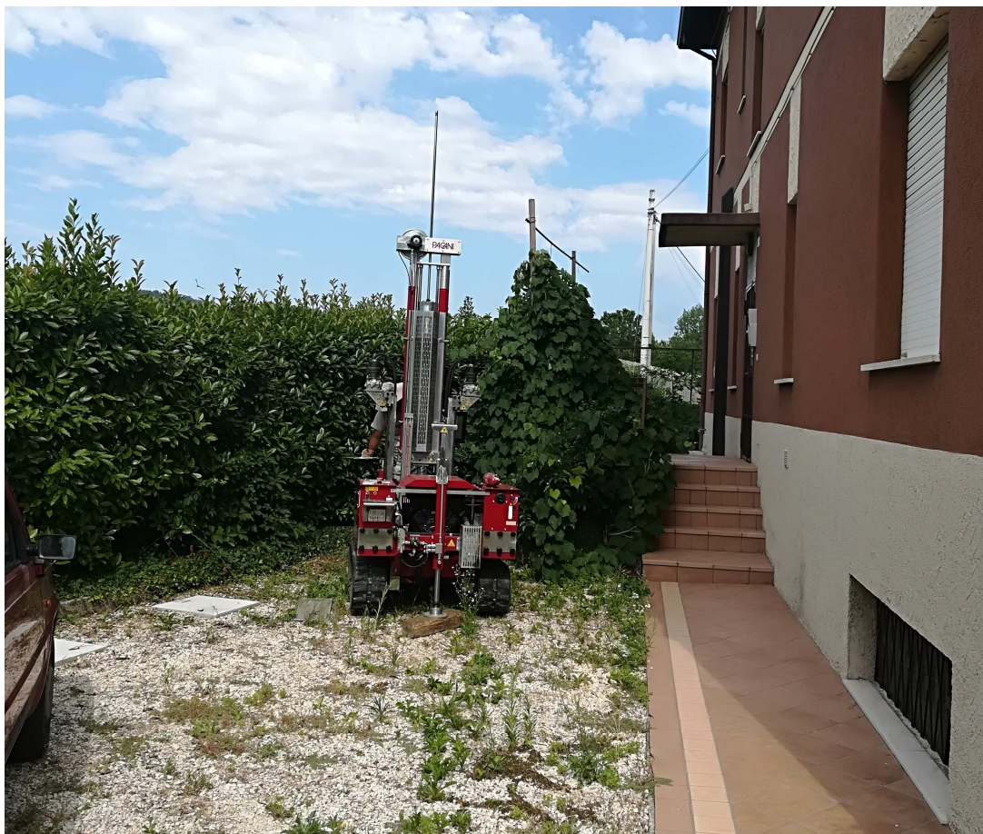
Fig. n.19 - Prova penetrometrica DPSH n.2 ed ambito di intervento visti da sud-est
