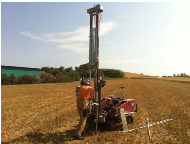
Foto 1 – Penetrometro Pagani DPSH, punto di indagine P1.
