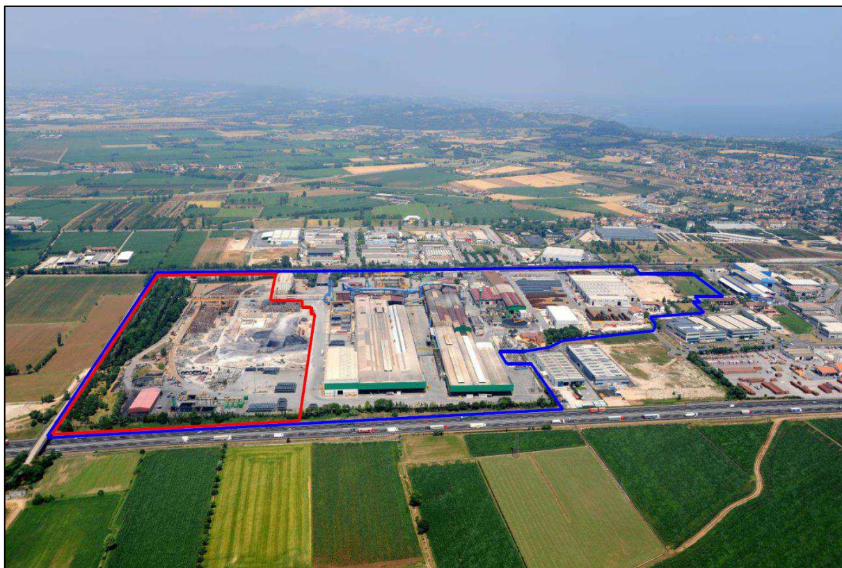
Foto aerea dell'intero insediamento produttivo FERALPI Siderurgica S.p.A. perimetrato con linea di colore BLU. L'area oggetto del PIANO ATTUATIVO in VARIANTE al PGT è perimetrato con linea di colore ROSSO.
